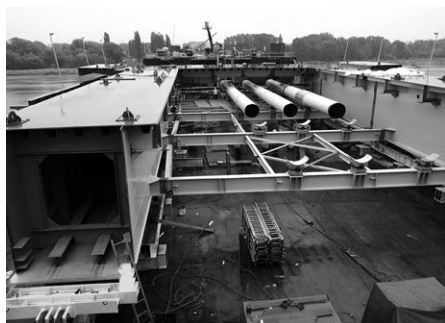
Rys. 8. Widok pomostu technicznego pod płytą ortotropową. Fot. M. Kieniewicz
