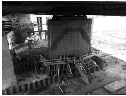
Rys. 9. Realizacja wzmocnienia konstrukcji podpór. Fot. M. Kieniewicz
