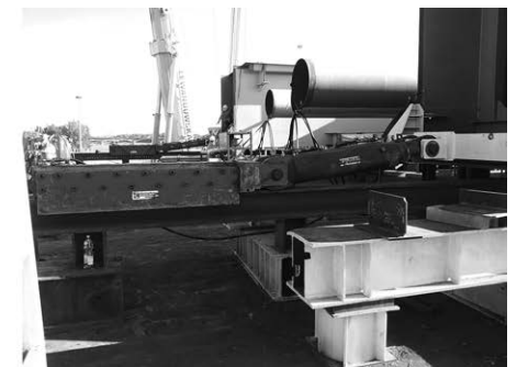
Rys. 14. Montaż i nasuwanie konstrukcji na opuszczonym fragmencie starej konstrukcji. Fot. M. Kieniewicz
