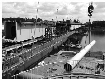
Rys. 14. Montaż i nasuwanie konstrukcji na opuszczonym fragmencie starej konstrukcji. Fot. M. Kieniewicz
