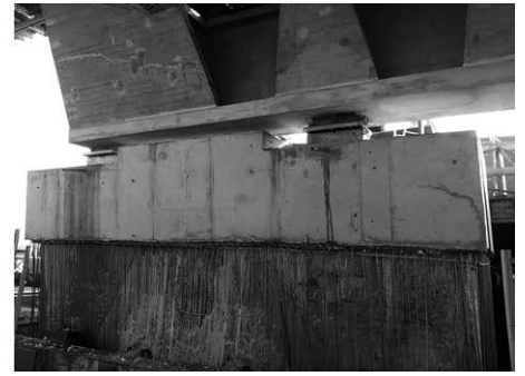
Rys. 9. Realizacja wzmocnienia konstrukcji podpór. Fot. M. Kieniewicz
