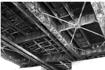
Rys. 3. Widok mostu (od góry i od spodu) po pożarze w lutym 2015 r. Fot. M. Kieniewicz
